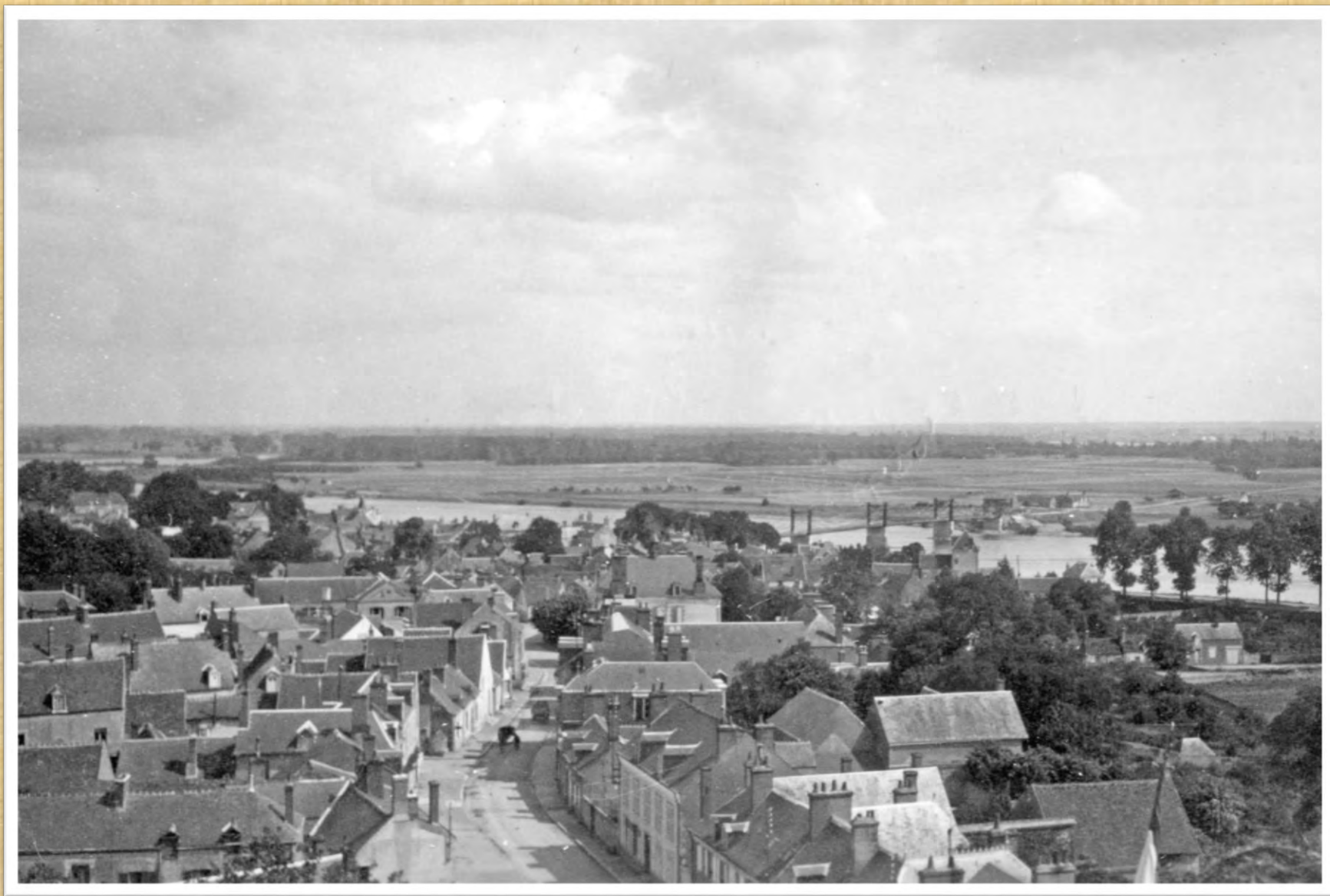
Avant 1940: Grande rue du Port, vue depuis le château d'eau
