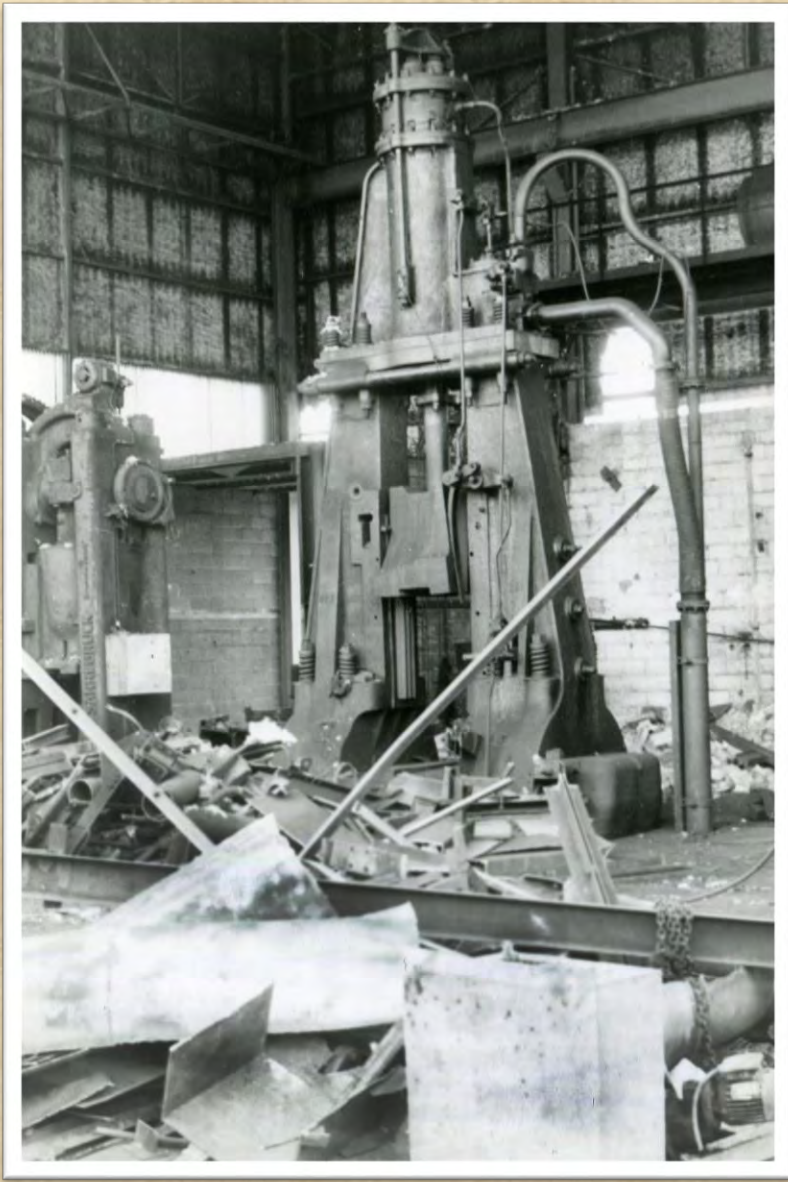
Le marteau pilon lors du démantèlement des locaux
