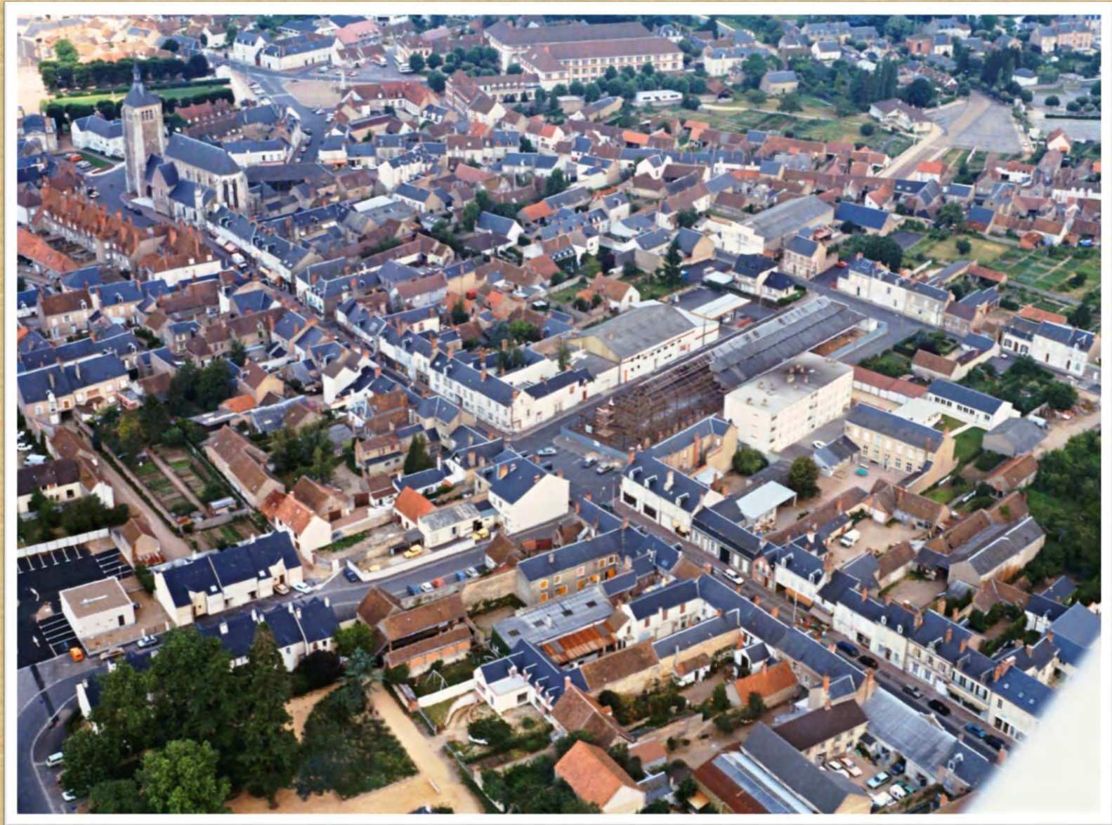
Grande rue Centre-Ville, travaux Nouvelle Halle dans le sens Est vers Ouest
