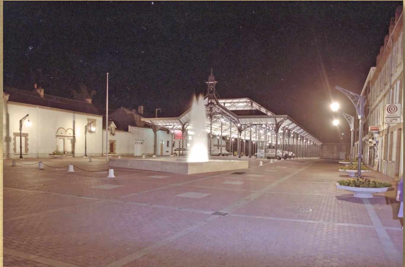
1987 / 1988: La halle est restaurée et réduite de 2 travées « Sud » pour aménager une place
