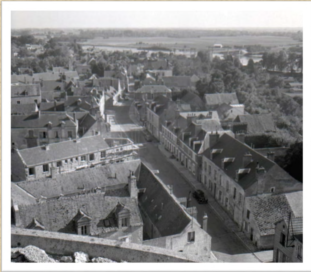
1955 /1963 : Reconstruction. La grande rue du Port. Îlot B
