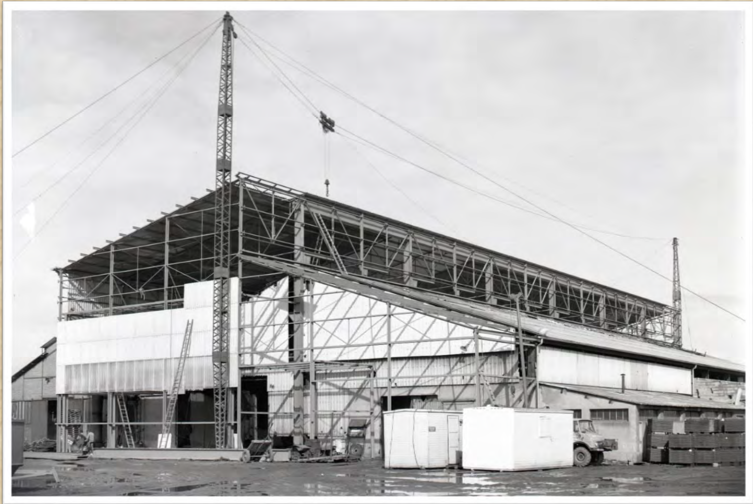
Extension de l'usine DEMANGEL par BAUDIN -1970
