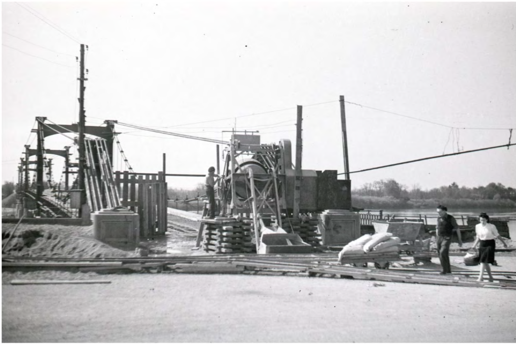
1946 : Le pont en reconstruction
